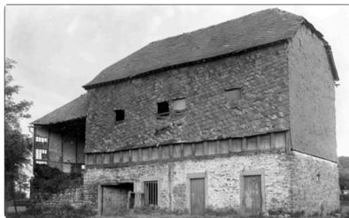
En 1945, l'ancien séchoir de la tannerie, à la hauteur de la laiterie de Mathilde Bréda. Photo IRPA.
